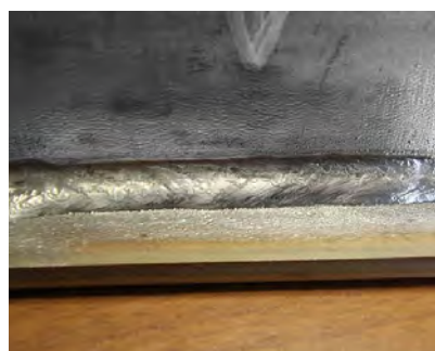
Сварка таврового соединения нержавеющей стали сплошной проволокой MIG ER-308LSi (Св-04X19Н9) диаметром 1,2мм в импульсном режиме.
